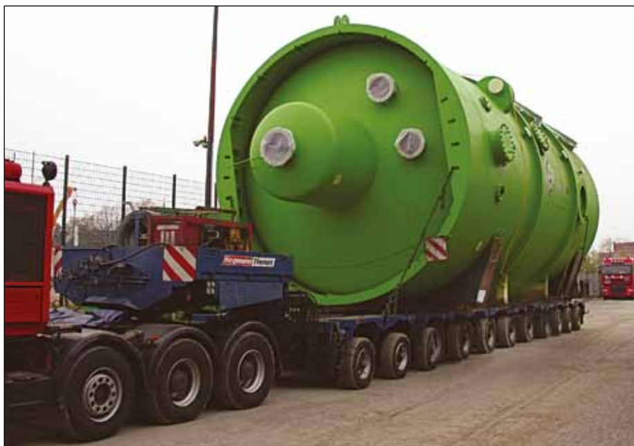
Рис. 5. Монтаж пластинчатого выпарного аппарата Groningen (Нидерланды) 6000\text{ м}^2
